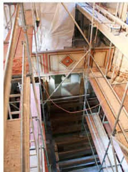
Das gesamte Kirchenschiff ist eingerüstet. Dies ist der Blick aus der dritten Etage direkt unter der Plattform, von der aus die Gewölbe saniert werden, herab auf die Kirchenbänke.
