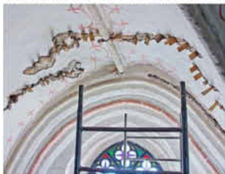
Mit vielen kleinen Keilen muss während der Arbeiten verhindert werden, dass Steine aus dem Gewölbe heraus brechen. Teilweise haben sich die Gewölbeschalen von den Außenwänden gelöst. Zuganker sollen in Zukunft verhindern, dass dieser Prozess weiter fortschreitet.
