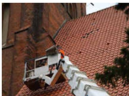
beheben. Fast immer an der gleichen Stelle, auf der Südwestmauer des Kirchenschiffs erzeugt Sturm einen solchen Sog, dass immer wieder Ziegel wegbrechen, obwohl sie geklammert oder geschraubt in einem Mörtelbett liegen.
