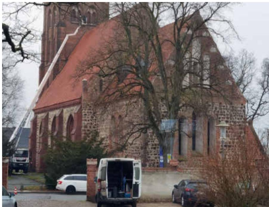
Gefühlt war es der 37. Dachschaden durch Sturm an der Gützkower Kirche. Nicht mal ein Dutzend Ziegel hat der Sturm aus dem Dach gebrochen, jedoch gut verteilt auf der gesamten Fläche der Südseite. Ohne Hebebühne, die mehr als 30 m hoch ausgefahren werden kann, war der Schaden auch dieses Mal nicht zu
