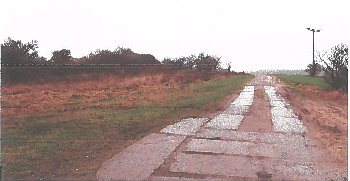
Bild 09 östliche Plangebietsgrenze mit Brombeergebüsch links Freileitung rechts
