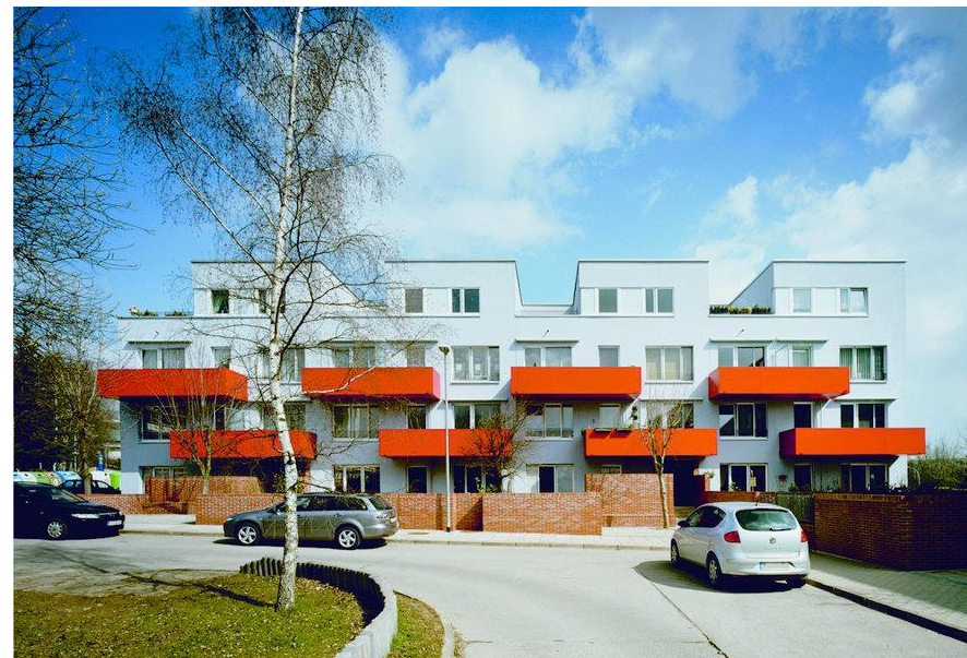
Abb. 81: Ansichten vorher und nachher modellhafter Umbau Quelle: LWG Leinefelde
