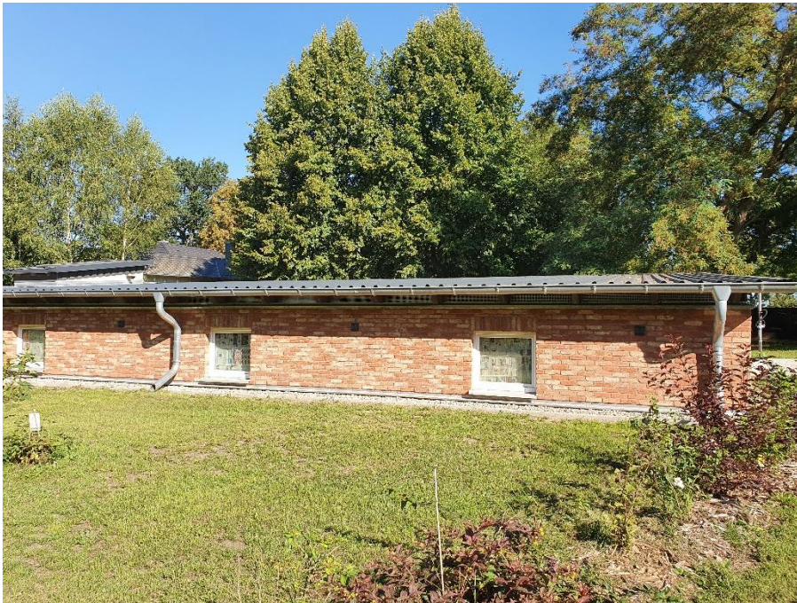
Abb. 2: Grundmauern des ehemaligen Verwaltergebäudes mit Flachdach
