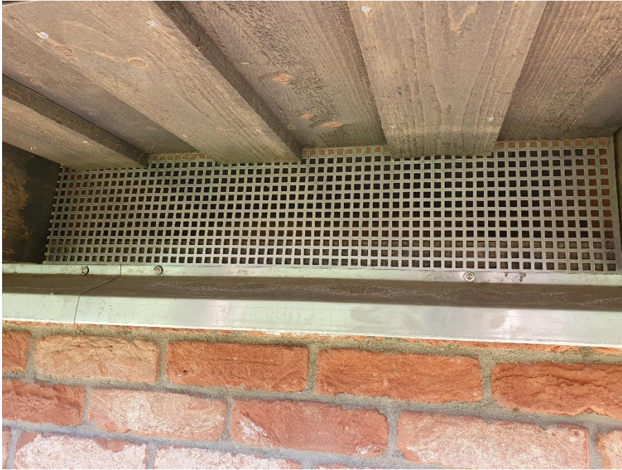
Abb. 3: Engmaschiges Gitter unter dem Dachvorsprung gegen Einflüge ins Innere
